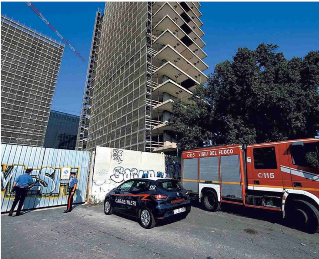
Il cantiere delle Torri dell'Eur, in viale America a Roma, da cui è precipitato l'operaio
